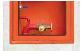
FIGURA 12 Hidrante exterior
